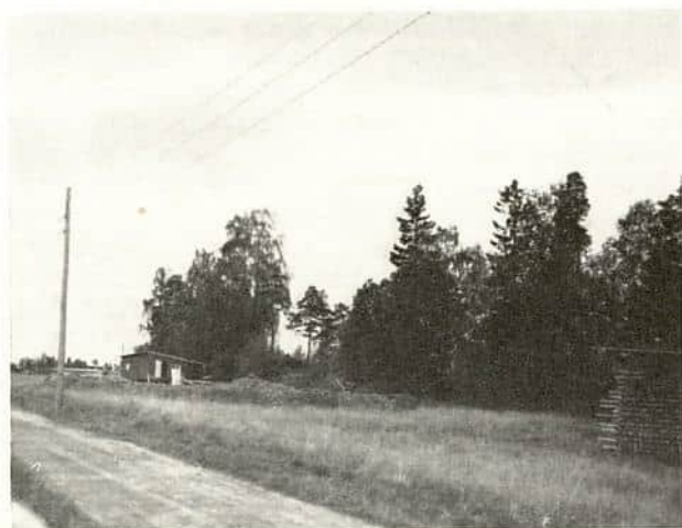
Bølerveien med byggelagets arbeidsbrakke i bakgrunnen.
