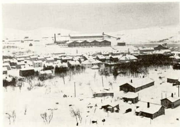
Separasjonsverket med Kirkenes by i forgrunnen.
