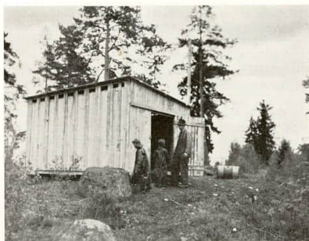
Byggelagets formann Eilif Pettersen ved kompressorhuset.
