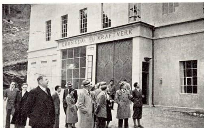
Foran inngangen til Grønsdal Kraftstasjon.
