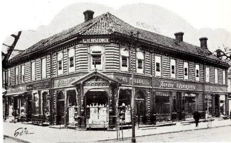
Midt i byens sentrum, i Nordre gate, sto denne gården som nå er under rivning.
