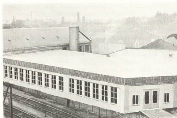
— og som en fugl Fenix oppsto et nytt bygg på rekordtid.
