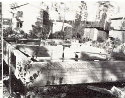
Grunnmur for Nordvang og Hannestad.
