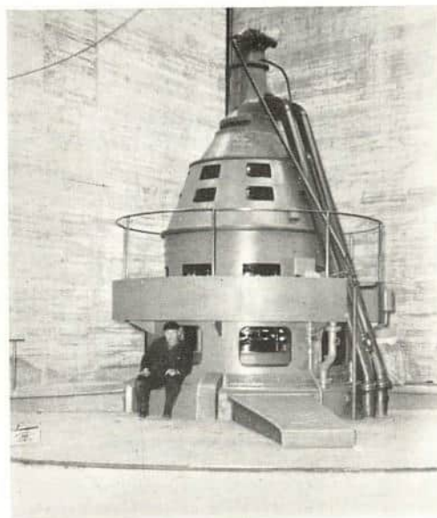
Den synlige del av generatoren etter at arbeidet er ferdig.
