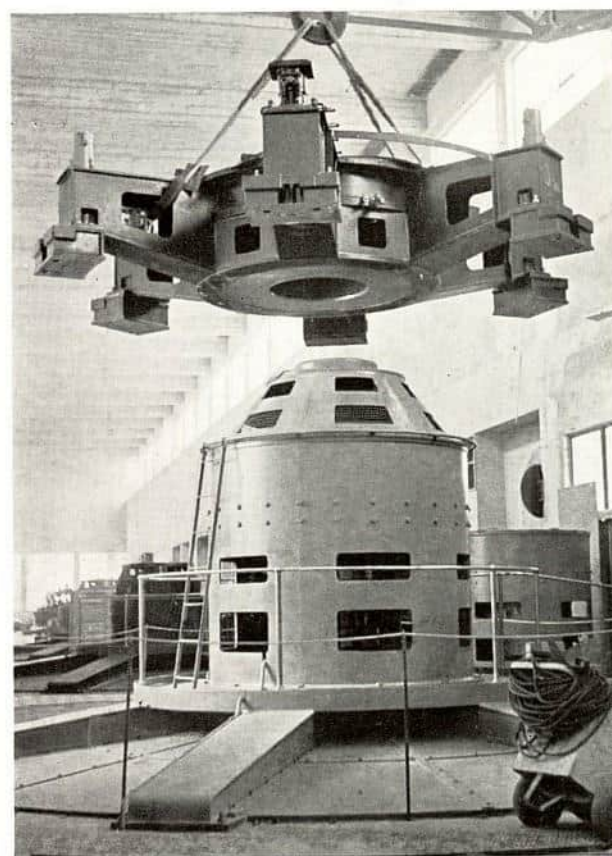
I kranen sees armkorset til generator 4, Hafslund. Bakenfor den ferdige generator 3.
