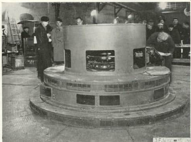
6. Fra idriftsettelsen. Forrest fra venstre ingeniørene Hofstun, Stenwig og Reinhardt, montør Hofler til høyre, montør Thomassen bak rekkverket til høyre.
