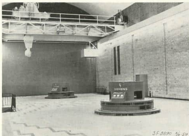
1. Den ferdige stasjonshall.
