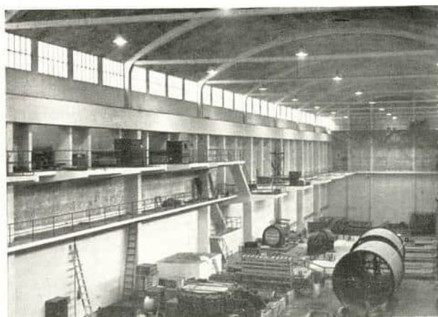
Mølle- og finknuseverk. Flotasjonsverk. Mølle- og knuseballen.
