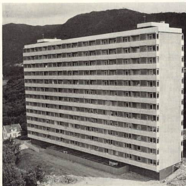
Høyblokken sett fra 10. etasje i den annen. Se kontrasten til det eldre 2. etasjes bygg til venstre. Råbygget på høyblokken var unnagjort på 4 måneder.
