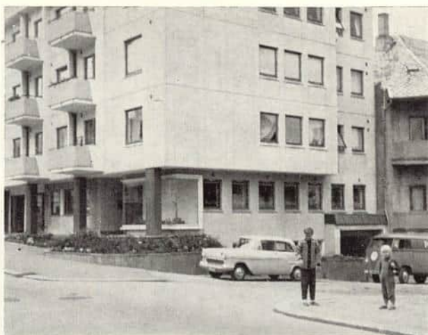
Huset som vi «bor» i. I 1ste etasje og kjelleren holder vi til.
