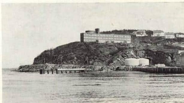
De Maritime Skoler i Trondheim. Rotunden er den runde «bygningen» på taket.
