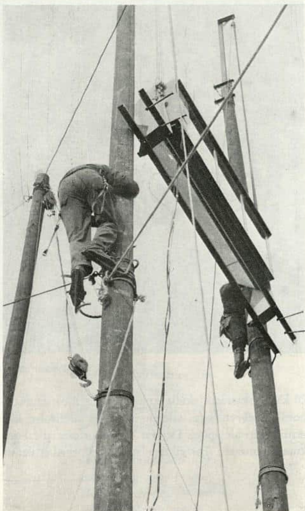
Kraftselskapets monterer i ferd med å heise den 230 kg tunge og nesten 3 m lange lyskasteren på plass.
