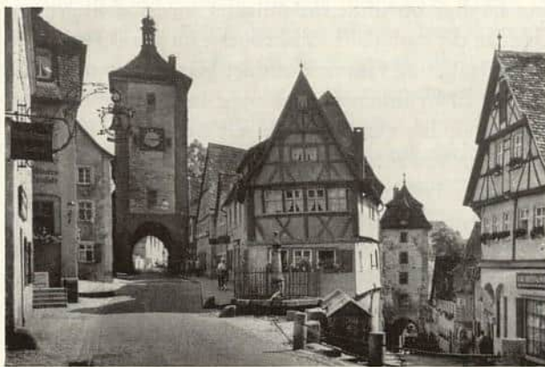
«Den gamle smien». Både huset og tårnet ble ødelagt under krigen, men er gjenoppbygget nøyaktig som det var før.
