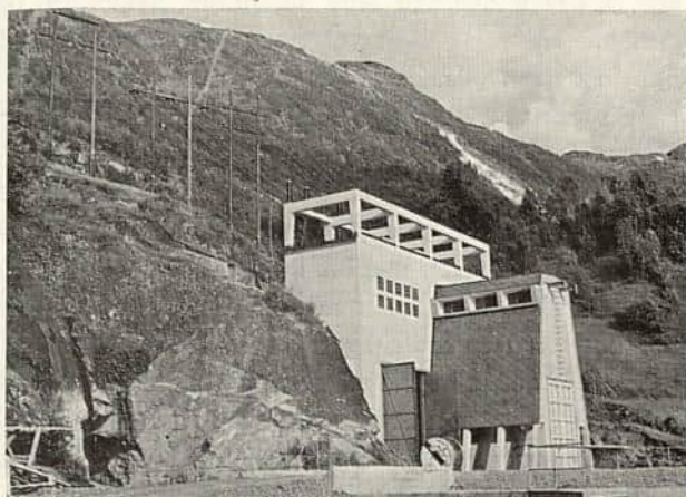
Portalhus for Tussa Kraftverk.
