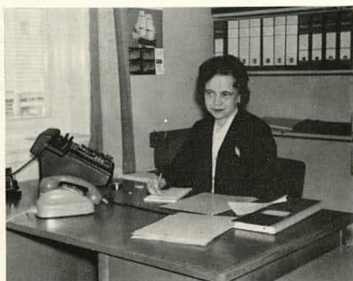
Anleggsavregning: Frøken Rosendahl.
