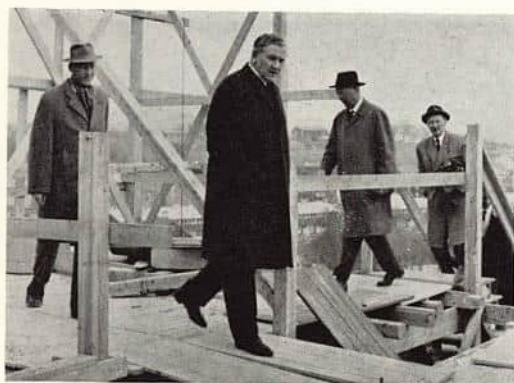
Selmer, F. Christensen (TCE) Hellesvik og byggeleder ankommer taket på administrasjonsbygget.
