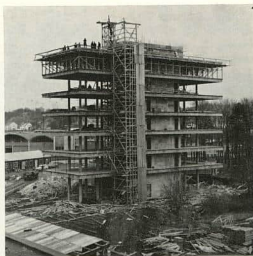
Administrasjonsbygget sett fra taket på verkstedbygningen etter at festligheten har funnet sted.
