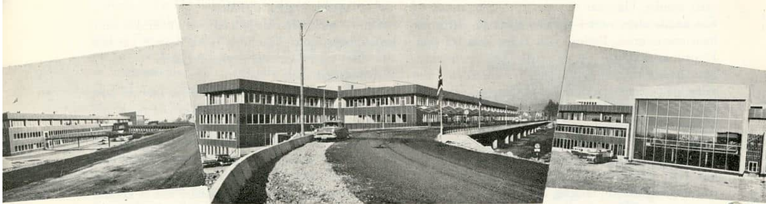
Bygget sett fra flyplassen.
