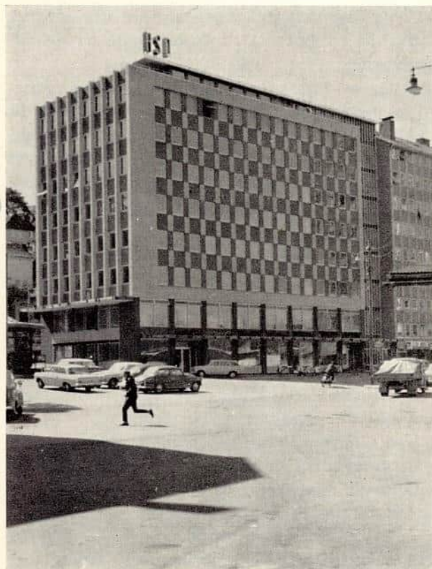
Nybygget til Hardanger Sunnhordlandske Dampskipsselskap i C. Sundtsgt.
