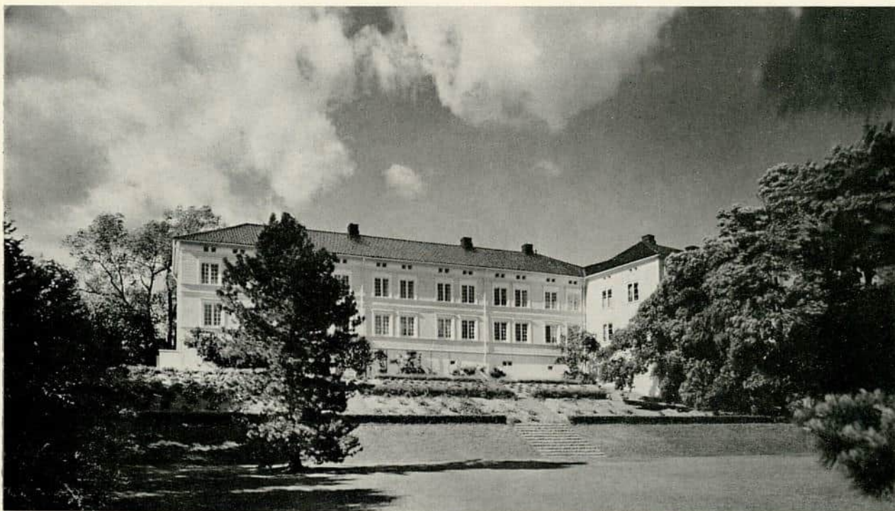
Bilde 3. Hovedbygningen på Linderud fotografert fra haven mot nord. (Teigens fotoatelier).
