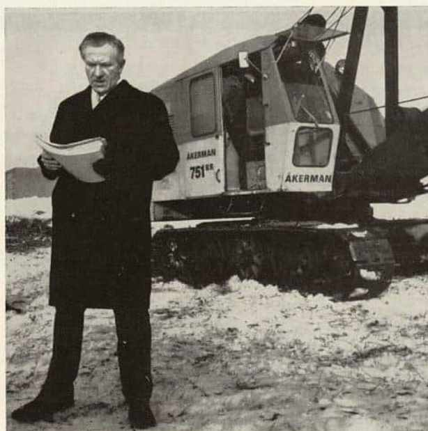
Adm. direktør Thv. Selmer kikker litt på planene før han setter seg inn i gravemaskinen for å ta det første spadetak på den 61 mål store tomten hvor Siemenshuset skal reises.
