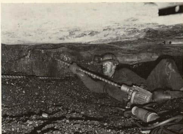
Boring i Kullskuffen inne på strossa.
