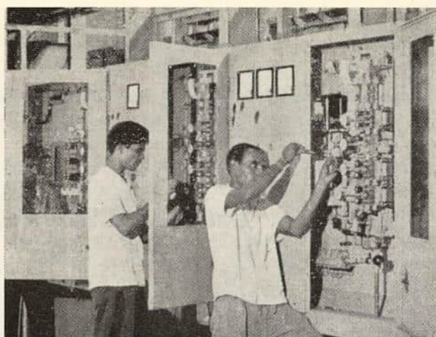
Montasje av Klinoscope undersøkelsesboder på røntgenavdelingen, Worli-verkene.
