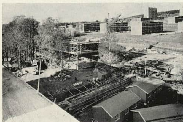
Verkstedbygget primo oktober 1968 sett fra øst på kontorbyggets gulv i 6. etasje. Legg merke til de gamle trær, og kulverten som er under utførelse for tørrskodd forbindelse under bakken mellom anleggets tre bygninger. (Fot. Sturlason.)
