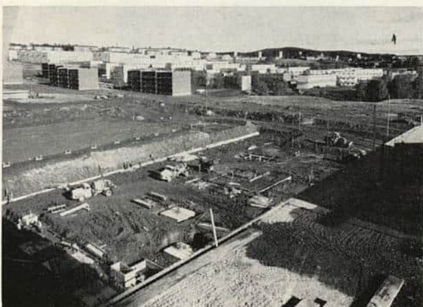
Lagertomten medio oktober 1968 sett fra syd på kontorbyggets gulv i sjette etasje. Fundamentene stopes. Bildet gir et godt inntrykk av grunnflatens størrelse. Ca. halvparten av bygget får underetasje. (Fot. Sturlason.)
