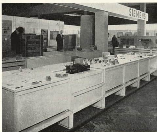
Regulatorer for prosessindustrien. Til venstre enkle av/på- regulatorer, i midten elektriske regulatorer, til høyre pneu- matiske og elektropneumatiske regulatorer.
