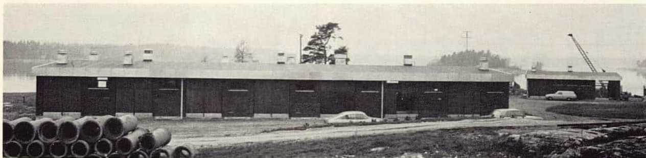
Moss Rygge Fellesvannverk.
