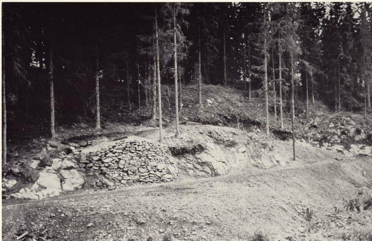
Fig. 1. I skråningen overfor veien er CTV, henholdsvis LPV for en stasjon forlagt.
