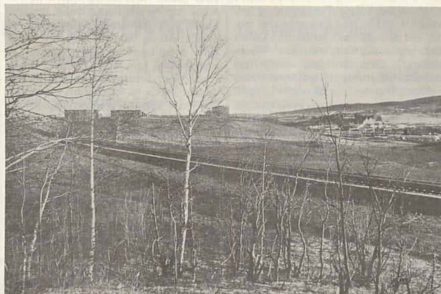
Tomten på østsiden av Grorudbanen (altså på "Siemens - siden") grenser til bane-traseen og strekker seg fra den skogkledd kollen nær Renault-anlegget og frem til den planlagte skoleidrettsplassen.
