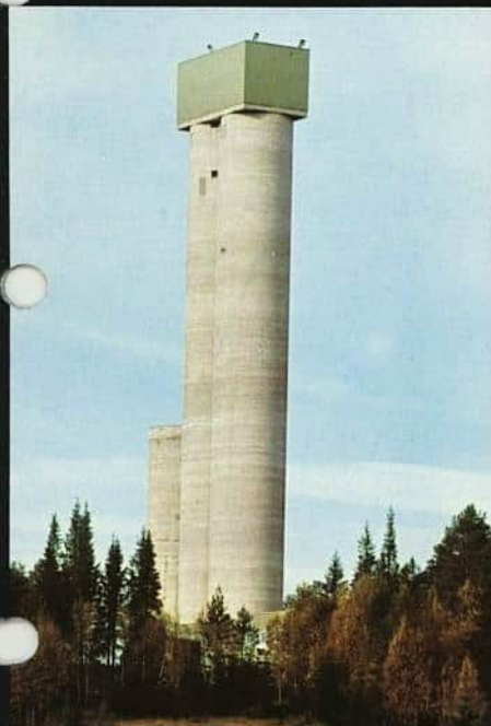
Løkken Verks nye sjakt, Astrup sjakt, er 1000 meter dyp og har fått et avansert, automatisk heisanlegg.
