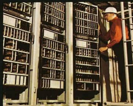
Fra monteringen av det automatiske system for fjernstyring og kontroll av ubemannede kraftstasjoner i Røssåga. Til anlegget hører en Siemens datamaskin som protokollerer alle opplysninger vedr. driften.
