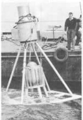
Bildet viser nedsenkingen i Nordsjøen. Nederst på stativet ser vi det 83 cm høye og omtrent 1,4 tonn batteriet. Øverst måleapparatet.
