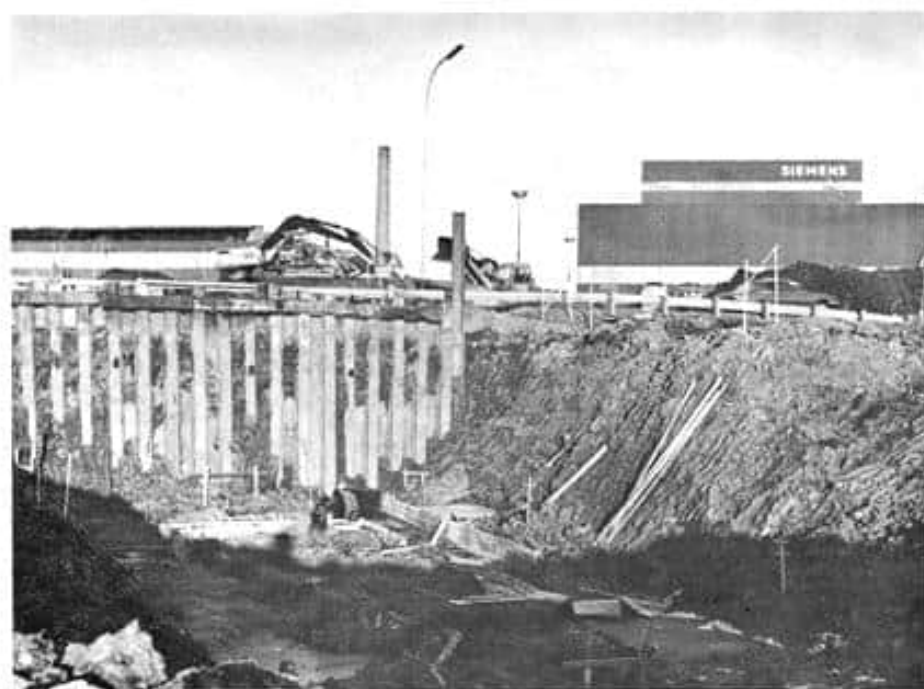
Første byggetrinn er en tunnel under Omkjøringsvegen. Som det fremgår av bildet er arbeidet kommet godt igang.
