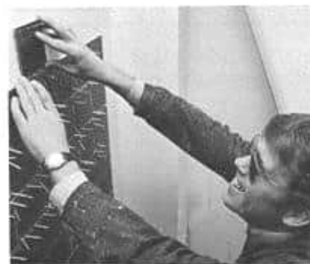
Per Knotten legger selv flisene på badet. Fyrstikkene bruker han som avstandspinner. Familien vurderer egeninnsatsen til 35 tusen, så man har ikke vært plaget av fritidsproblemer i det siste året.
