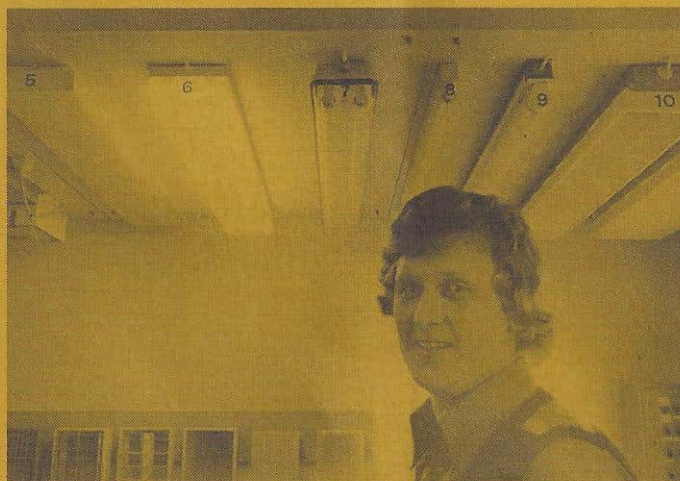
Einar Marthinussen kan demonstrere hele programmet vårt av interior- og industriarmaturer i Sundtsgate i Bergen. Nå slipper han all riggingen når installatorkundene hans ønsker å se armaturene i funksjon.
