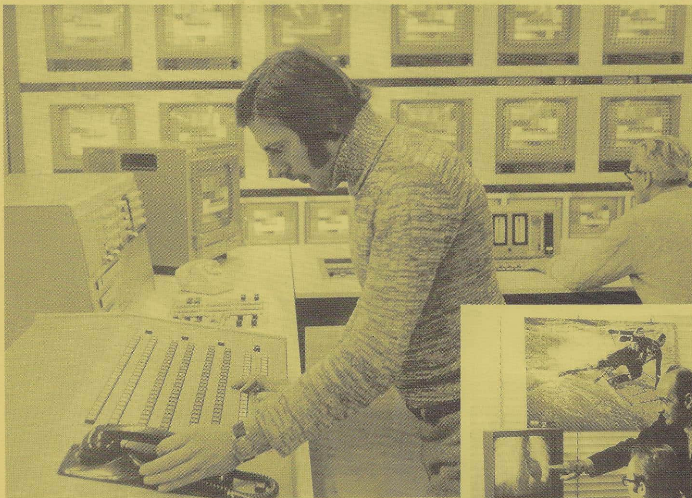
Siemenseksnikere har brukt ca. 100 "mannemåner" til innredning av studio for TV- og radiooverføringer. I de to sentralene er lagt mere enn 60 km kabel.
