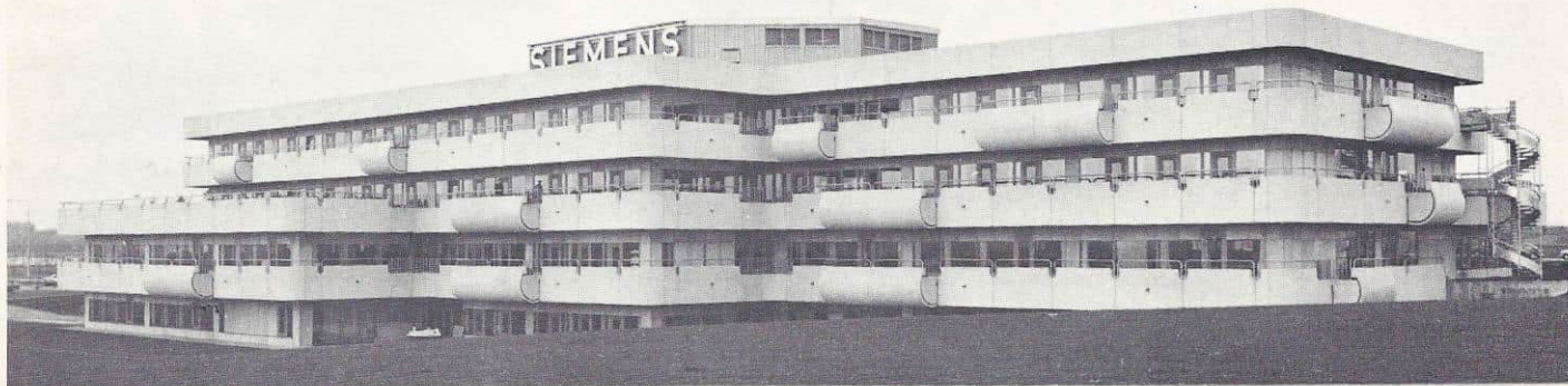
Slående arkitektonisk trekk ved Siemens nye kontorhus i Ballerup er de svungne, fyldige balkonger. - Avrunder bygningskroppen, sier arkitekten. - Romerske stridsvogner! sier direktøren.
