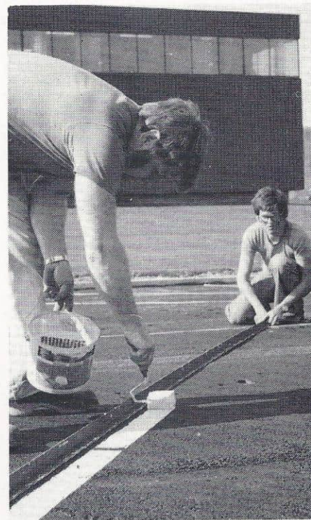
Parkeringsplassen ved hovedlageret i Trondheim er nå utvidet, planert, asfaltert og merket. De av våre ansatte som har brukt området som parkeringsplass i 14 år vet å sette pris på standardhøyningen. På bildet er Tormod Eidsvåg (t.v.) og Alf Gilje iferd med å merke opp de 101 plassene.
