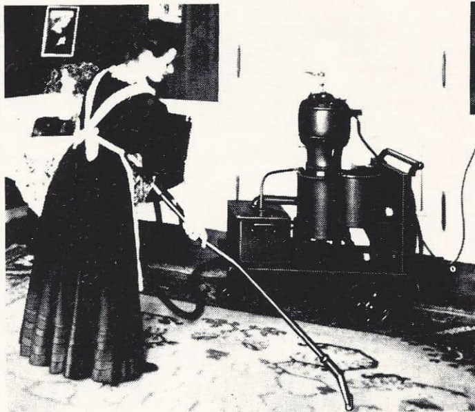
Den elektriske avstøvningspumpen var altså Siemens første støvsuger. Modellen er datert 1906 og det ble sterkt fremhevet at den var kjørbær (fantas det kanskje en annen versjon for to stuepiker, meis og bærestopper?).
