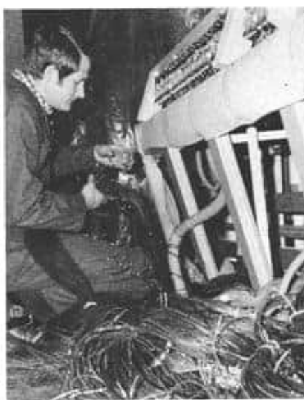
Bildet illustrerer det største problemet under arbeidet - mye oppkobling og dårlig plass. Her er Nyhus som bakser med "spagettien".
