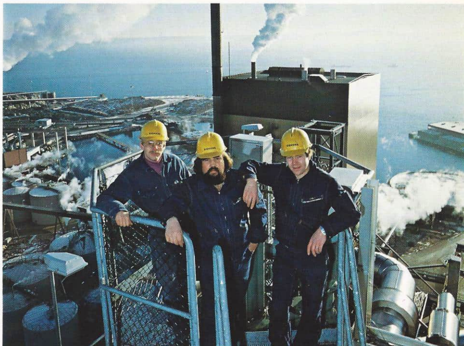
Tofte-anlegget har gitt oss store oppgaver i året som er gått, og dette bildet ble tatt øverst i rensetårnet i høst. Siemens-montørene er fra venstre Roald Hårstad, Odd Olafsen og Kjell Kvifte.
