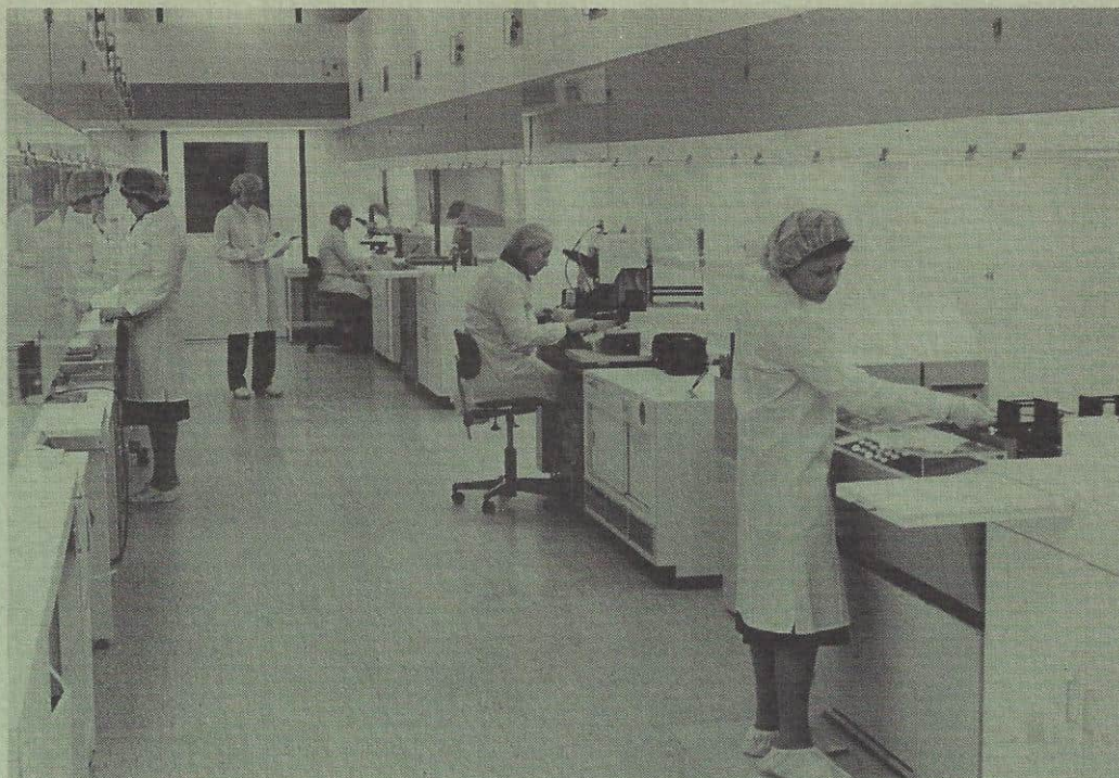
En av de to fotolitografiske avdelinger i den støvfrie del av Sipsmossenteret i München-Freimann. Til venstre i bildet foregår etseprosesser, til høyre pålegges fotolakk som senere belyses.
