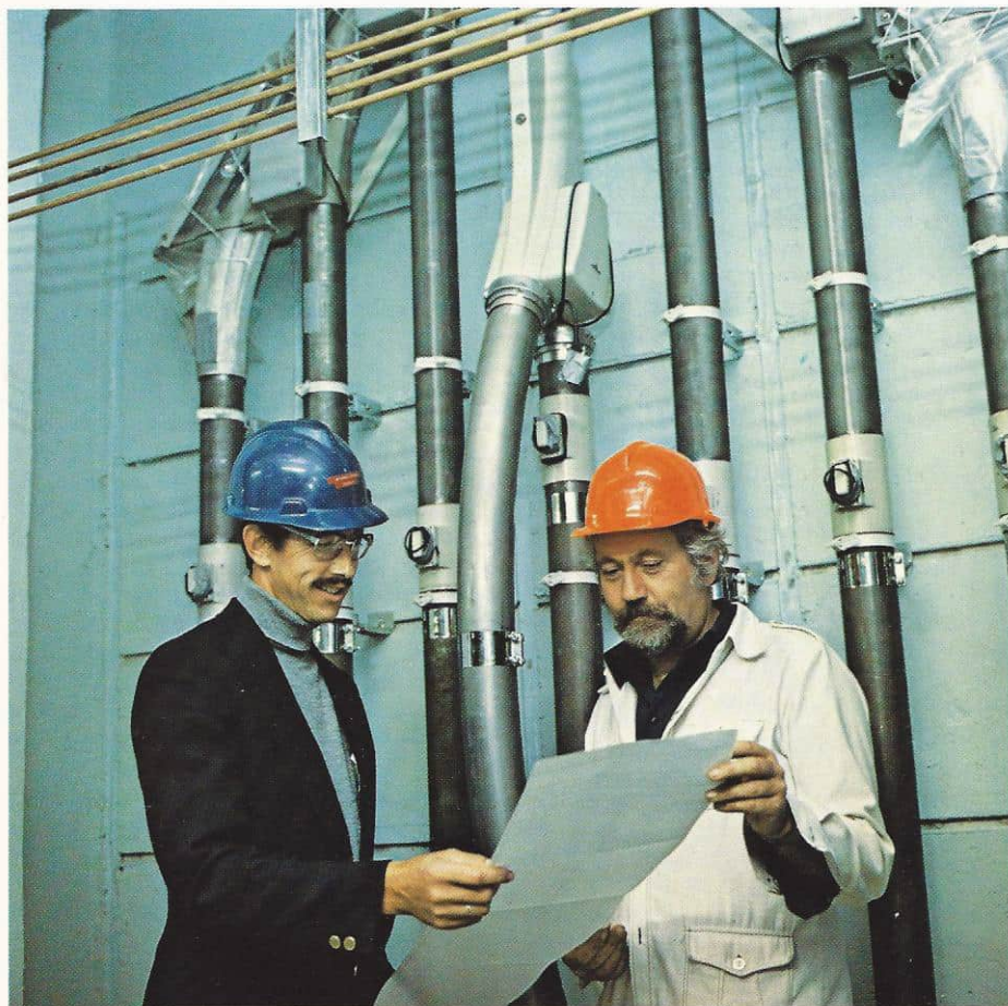
Til venstre ing. Sverre Lyder Kversøy, og til høyre ing. Per Vedaa. I bakgrunnen en av hovedpensene til rørpst-anlegget.
