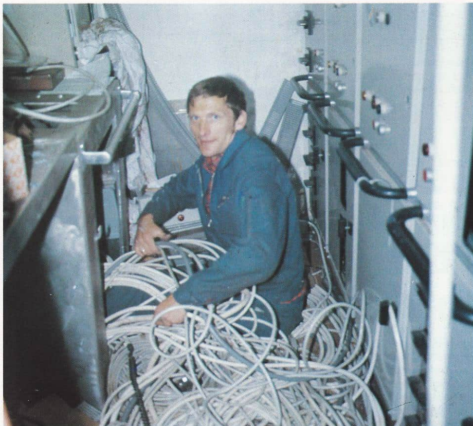
Montør Gunnar Liabø syns nok det er trangt på denne arbeidsplassen, men slik er det ombord på båter.
