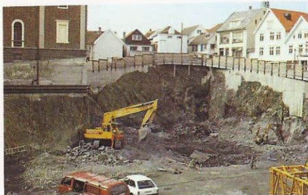
En mektig byggegrube midt i Stavanger sentrum — her skal det nye kulturhuset reises, og A/S Wikene har første del av den elektrotekniske entreprise.
