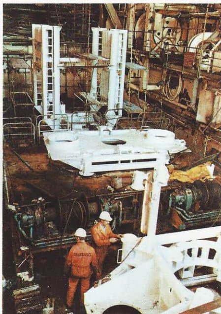
En "blow out preventer" blir montert inne i operasjonshallen. Den skal senkes ned på bunnen ved boring.
