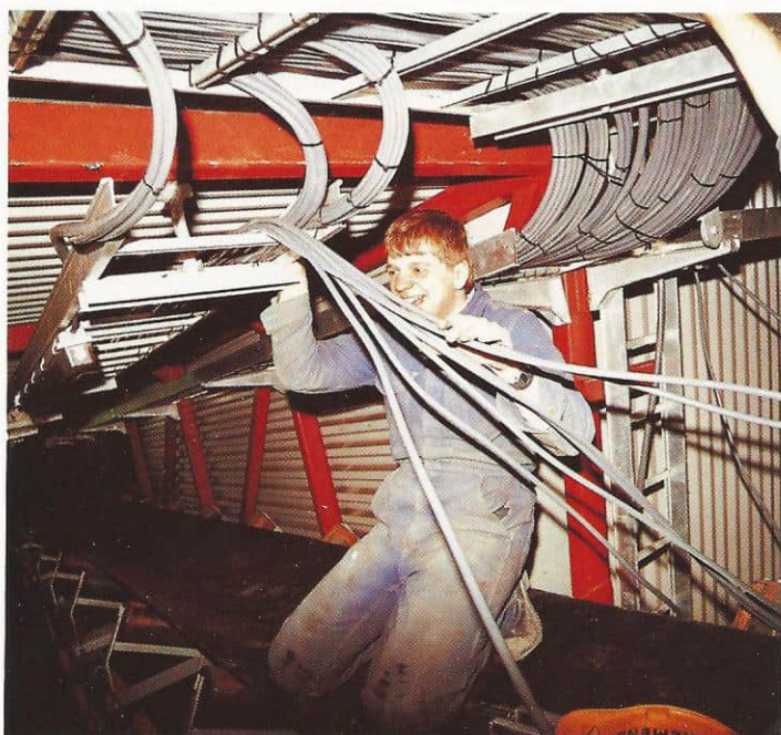
Kabelarbeide i Tyssedal. Men hvorfor har ikke Siemens-montøren hjelm? Svaret er enkelt: Det er ikke plass til den, hjelmen ligger foran ham på gulvet. (Foto Ø. Larsen).
