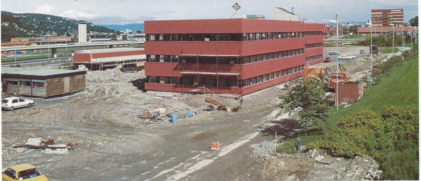
Det nye kontorbygget på Sluppen skal bli et eksempel på det sikkerhetsnivå Siemens skal ha.
