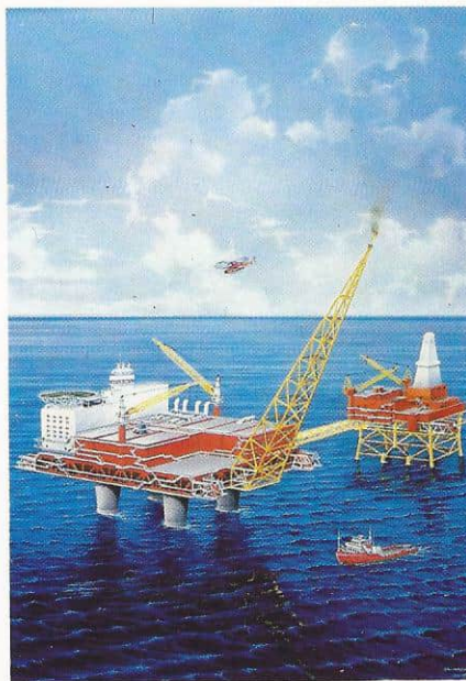
Modell av Osebergfeltets plattformer, slik de engang skal stå i sjøen. Boligplattformen med flammefløyten (t.v.) er knyttet til produksjonsplattformen med en bro.
