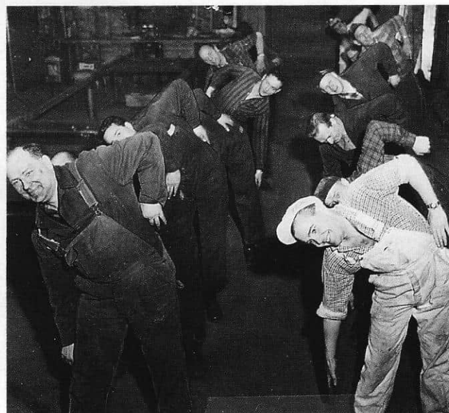
... og i Sterkstrømfabrikken
