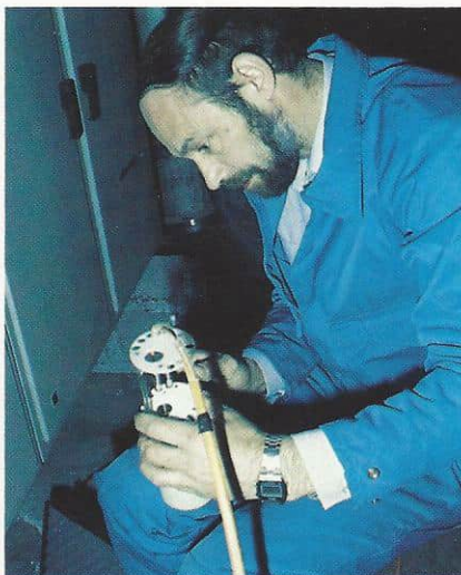
3) Når konnektoren er påsatt med lim, kokes konnektor og kabel for å herde limet. Ca. en time skal det koke for å være solid nok.
