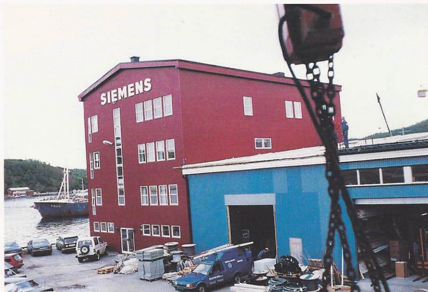
Nærmere sentrum enn før, og helt ut på kaikanten er Siemens Harstad kommet.
