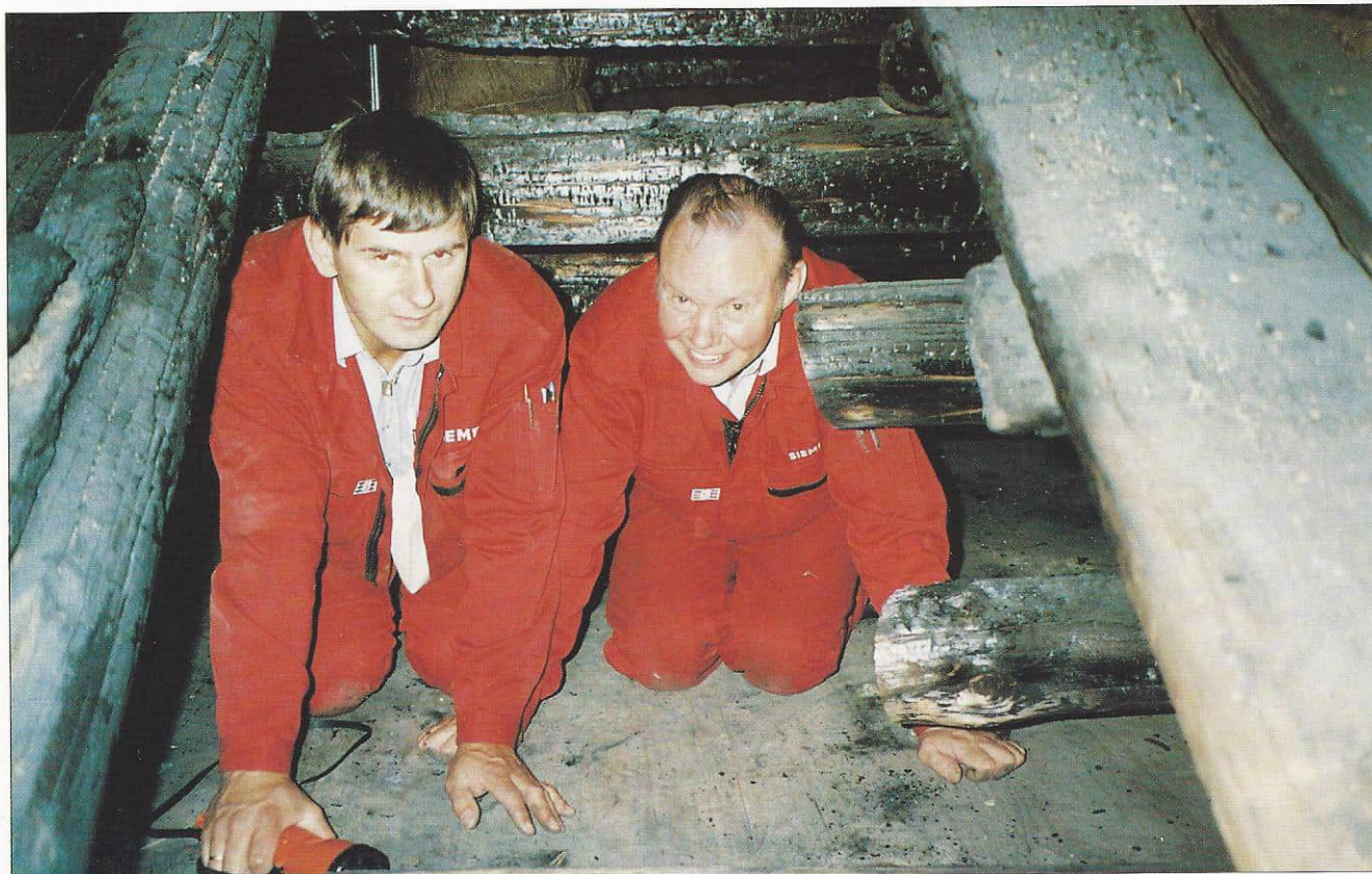
Ingenting skremmer brannservice-montørene når det gjelder arbeidsplass - her er Per Søyseth og Erik Haugnes på det utbrente loftet over bakeriet i Erkebispegården i Trondheim.
