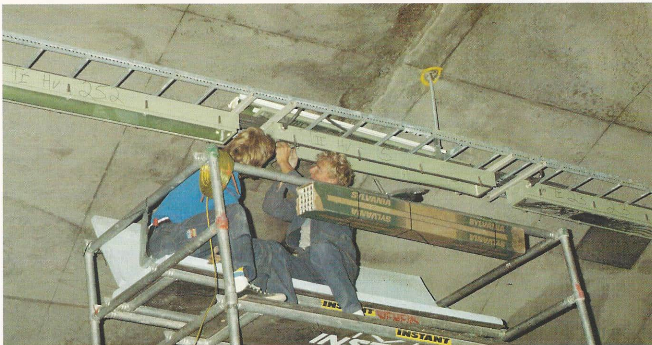
Byggingen av Fjellinjen har betydd arbeide for våre montører i en vanskelig tid. Oppmontering av armaturer for veibelysning, avtrekksvifter og trafikkstyringsanlegg er de viktigste arbeidsoppgavene inne i tunnelen.
