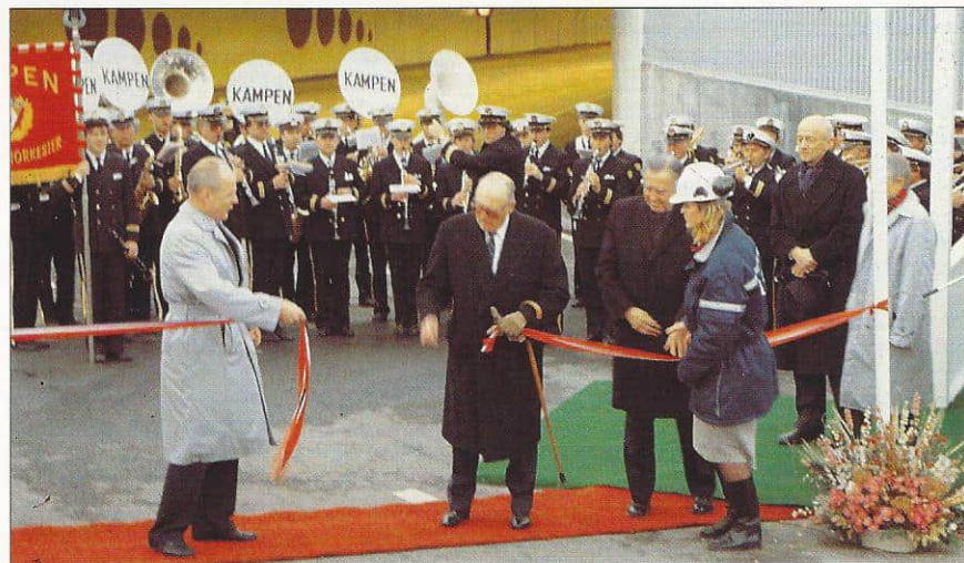
Kong Olav åpner første del av "Fjellinjen" - Siemens har bidratt til at det skjedde til planlagt tidspunkt.
