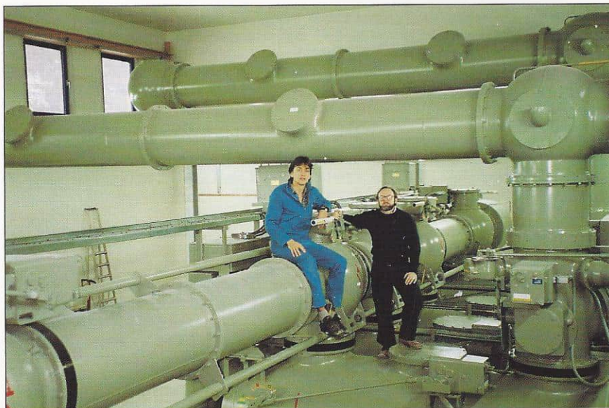
Dette er topp moderne teknikk for en sekundærstasjon. I rørene er det 132 kV spenning, men du kan trygt sette deg på dem - slik Leif Ingar Stadheim har gjort. Ved siden av ham: Per Chr. Hansen.
