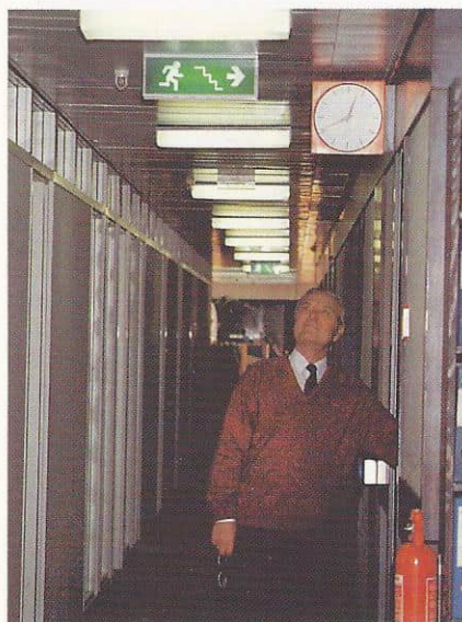
Mye nytt verneutstyr er kommet opp på Linderud i den senere tid. Egil Jacobsen konstaterer her at "den grønne mannen" lyser ved en av rømningsveiene i kontor- bygget.
