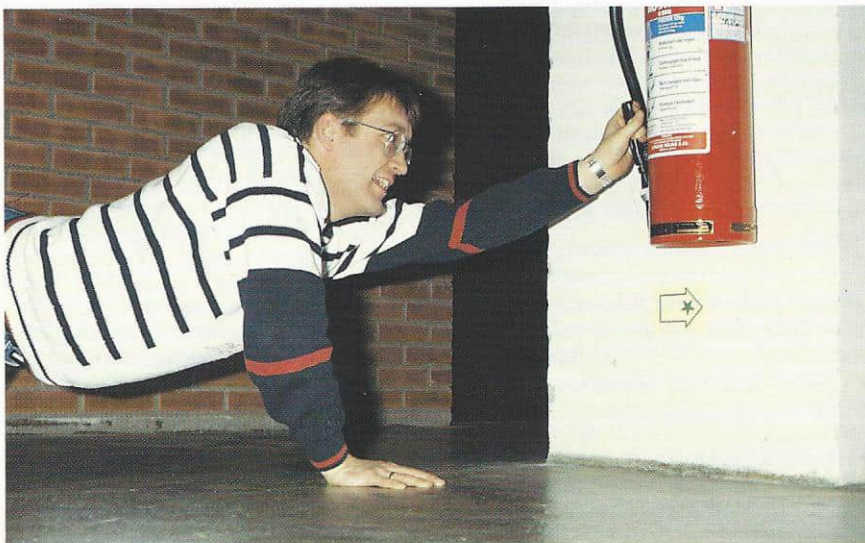
I kjelleren på Forum er det montert grønne, selvlysende piler nær gulvet. Blir det røkdannelse i rommet, kan du krype langs guvet i riktig retning og finne frem til brannslukningsapparat og utgangsdør.
