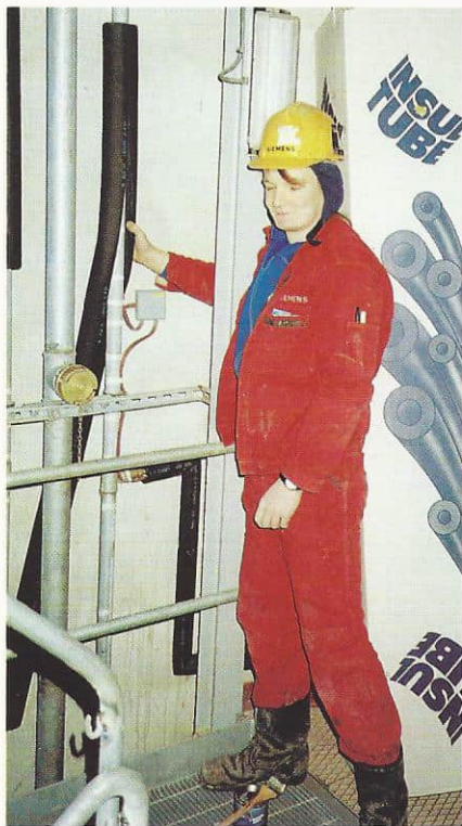
Isolasjon er mer enn beskyttelse mot elektriske støt - i hvert fall for en Siemens-montør. Tore Hansen, S/Kjøpsvik er her ivrig opptatt med isolering av rør.
