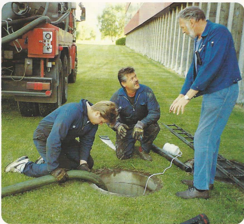
Ragnar Kvarme, Siemens og representanter fra Veglo Miljøservice tømmer lagertank for spesialavfall.
