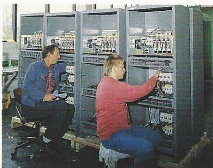
Tavlemontør Bjørn Evjen (t.v.) og Erling Neverdal monterer fordelingskap for NetCom.
