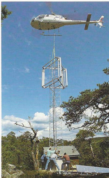
En 1100 kilos mast fra oven. Den skal styres med millimeterpresisjon ned på fundamentet, hvor bolter og muttere er klar. Det betyr full konsentrasjon fra Edmund Henriksen, Steinar Ulvøy og Rolf Erik Lervik fra Siemens, Roger Kvannefoss og Peder Bjarne Grønås fra Linjebygg og piloten.
