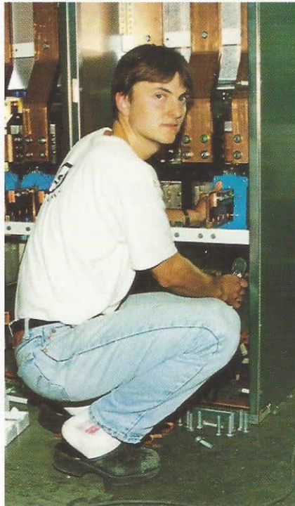
Ketil Andreassen monterer innmat i S404-tavler. Disse skal ombord i en kjemikalietanker som bygges i Florø.
